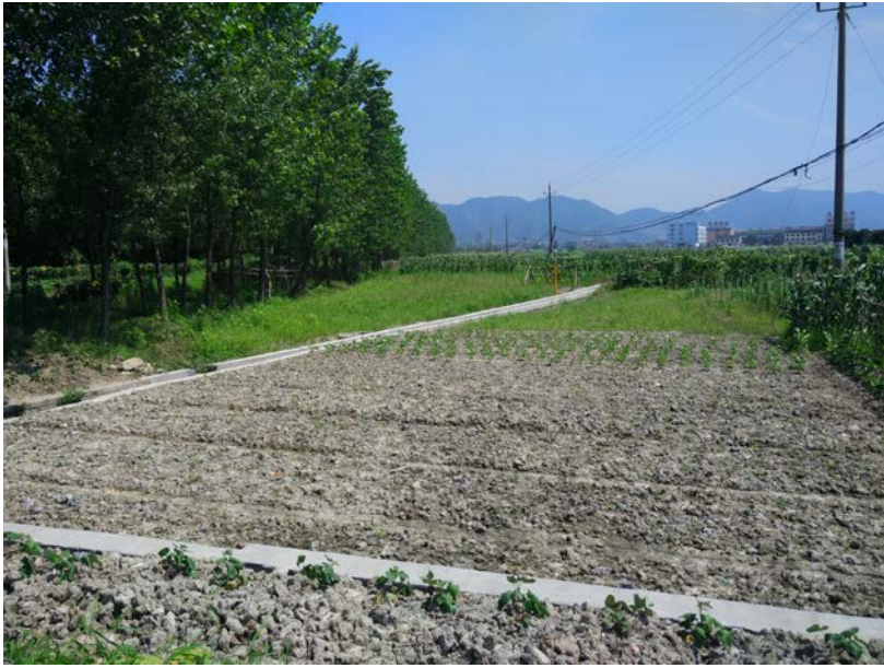
图 5 工程沿线恢复耕地
