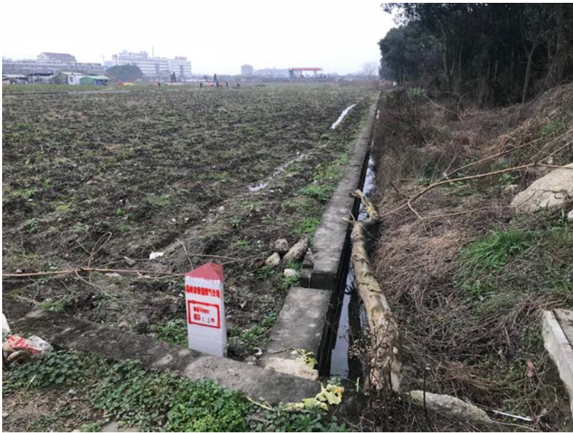
图 3 工程沿线恢复耕地
