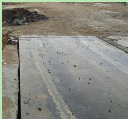
图 3-4 施工出入口洗车平台
