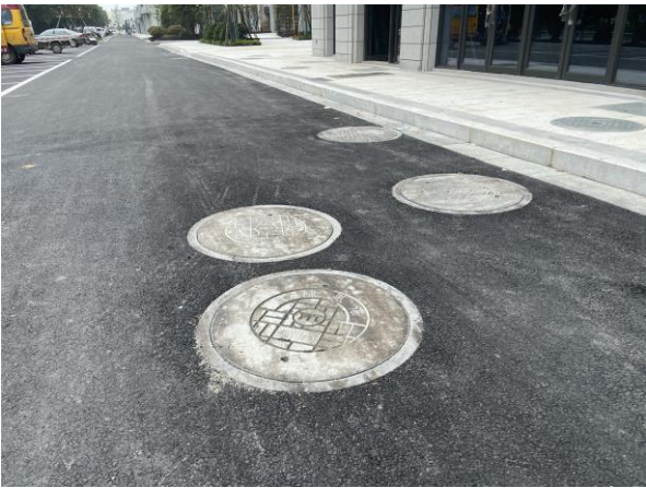
图3-1 排水工程雨水口（一）
