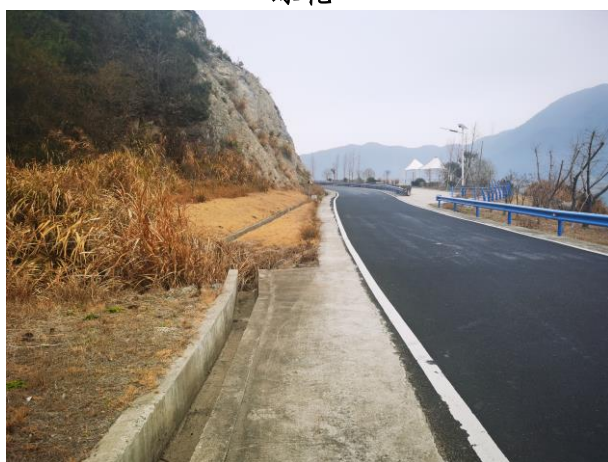
路堑边坡及排水边沟
