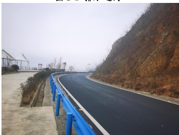
图 3-3 路堑边坡及排水边沟
