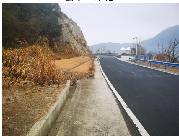
图 3-4 路堑边坡及排水边沟
