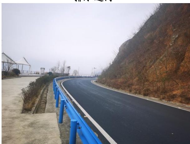
路堑边坡及排水边沟
